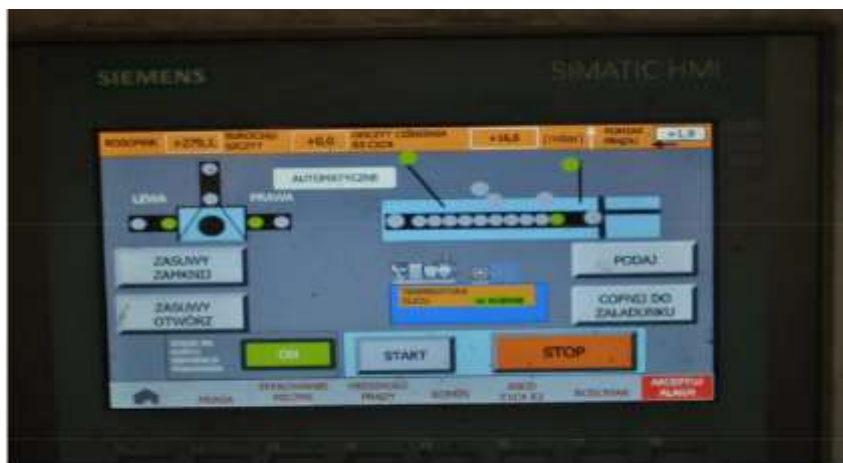
Слика бр. 5. Контролна табла уређаја за дозирање
